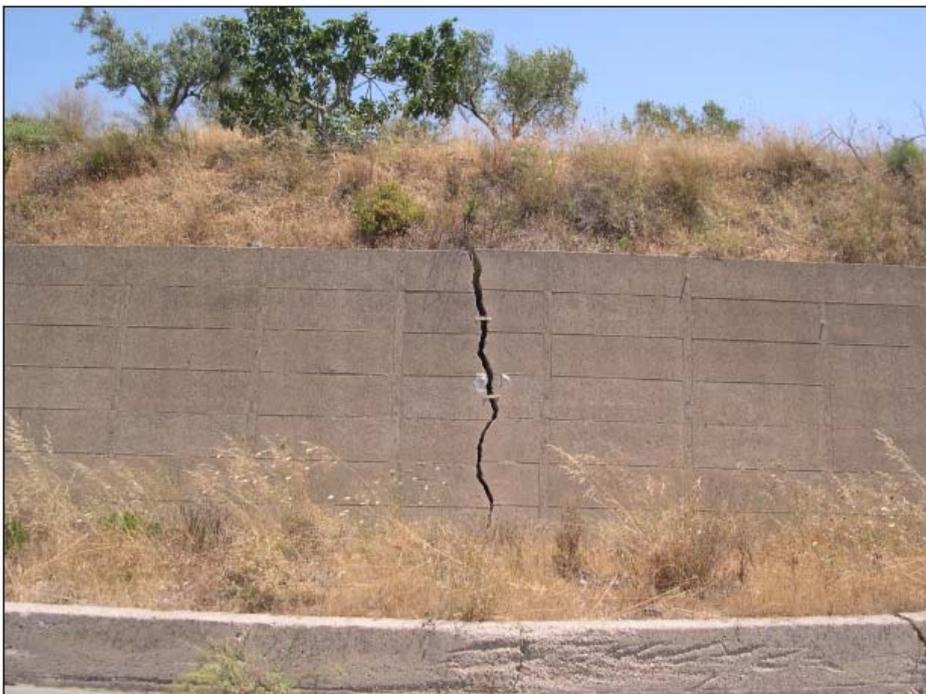
Foto A.3.1.13 Dissesto 077-2NI-077. Località S. Croce S.P.n.10 Comune di Niscemi. Dislocazione del muro di Contenimento per processi erosivi intensi.
