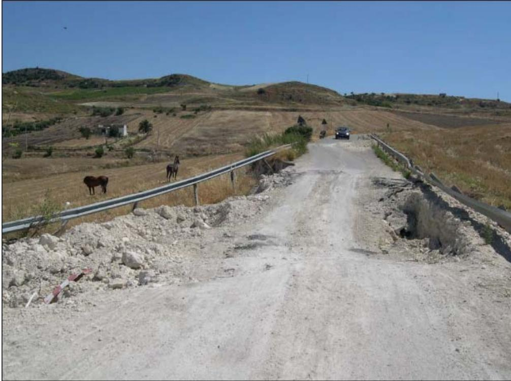
Foto A.3.1.14 Località versante del rilievo collinare posto a sud del Lavinaro Gargheria nella S.P.n. 81, Comune di Gela. Sprofondamento sede stradale per frana di scorrimento.
