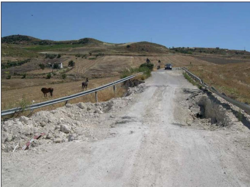
Foto A.3.3.1.14 Località versante del rilievo collinare posto a sud del Lavinaro Gargheria nella S.P.n. 81, Comune di Gela. Sprofondamento sede stradale per frana di scorrimento.
