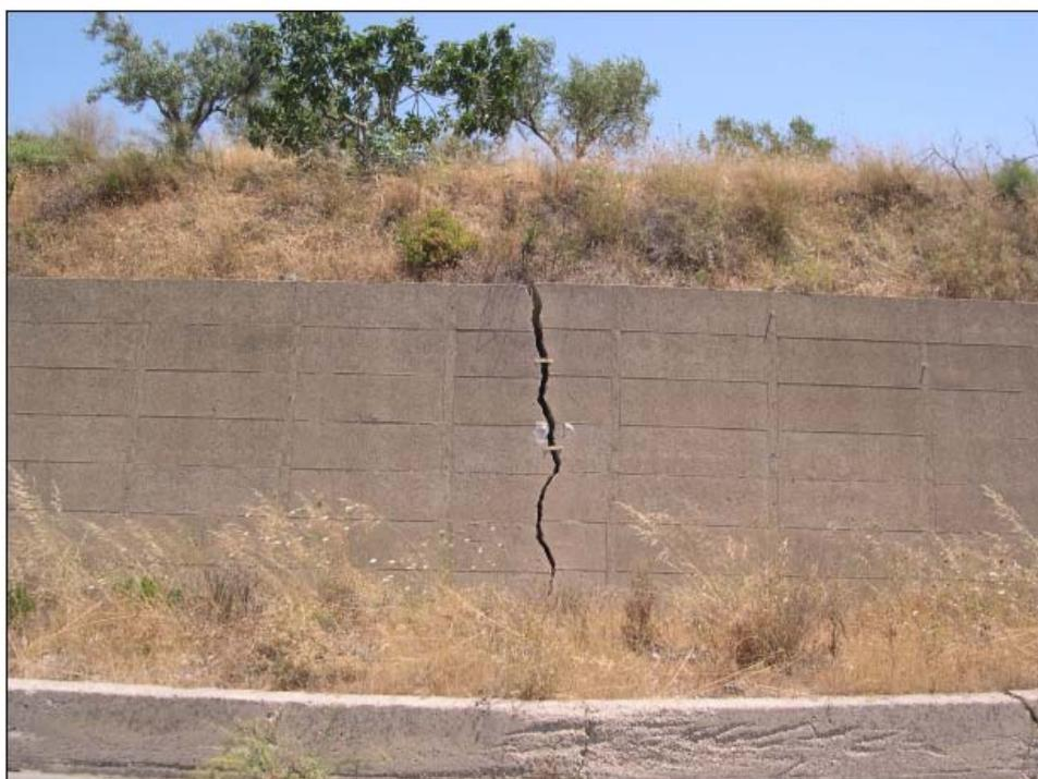
Foto A.3.3.1.13 Dissesto 077-2NI-077. Località S. Croce S.P.n.10 Comune di Niscemi. Dislocazione del muro di Contenimento per processi erosivi intensi.
